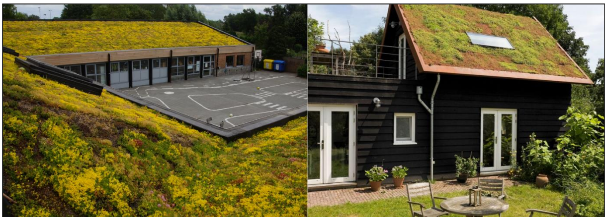
Figuur 35. Voorbeelden van een groendak. Links wordt een groendak toegepast op een groot, weinig hellend dak van de basisschool in Meerdonk Sint-Gillis-Waas. Rechts is het toegepast op het dak van een privé woning. Bron: Blauwgroen Vlaanderen.
