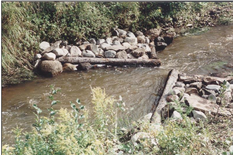
Figuur 61: Stroomdeflector met stenen en hout. Bron: www.afterwildfire.org .
