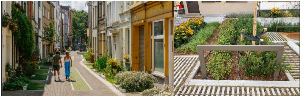
Figuur 18. Vlnr: (1) Ontharding met boven- en ondergrondse infiltratie in centrum Antwerpen. © Aquafin; (2) Infiltrerende plantvakken in Aziëlaan (tuinstraat Wilrijk). © Aquafin
