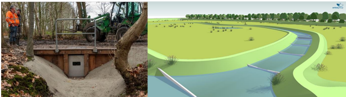
Figuur 64. Links) Regelbare knijpstuw Ulvenhouts bos (Nederland). Bron: Naturetoday.com. Rechts) Vispasseerbare drempels in waterloop afwaarts van natuurgebied. Zo wordt opstuwning gecreëerd zonder dat een vismigratieknelpunt ontstaat. Dit principe werd toegepast bij de herinrichting van 'de Hellekens' in Herentals. Bron: VMM.
