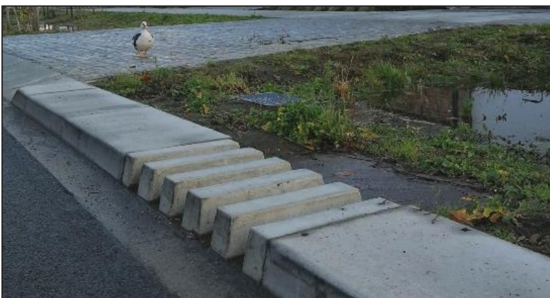
Figuur 29. Een voorbeeld van een boordsteen met spleten zoals toegepast in de Fortstraat in Mortsel (Bron: dbpubliekeruimte.info).
