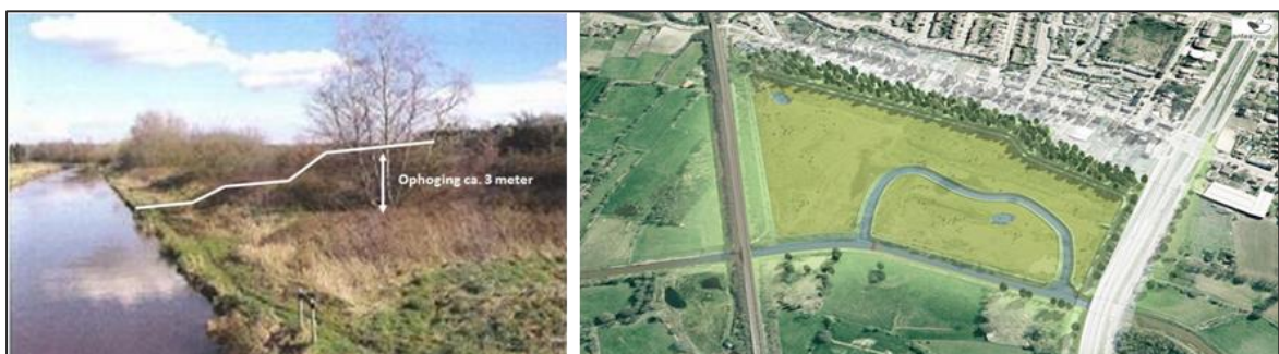
Figuur 63: Herinrichting 'Hellekens' te Herentals d.m.v. afgraven talud. Bron: VMM.
