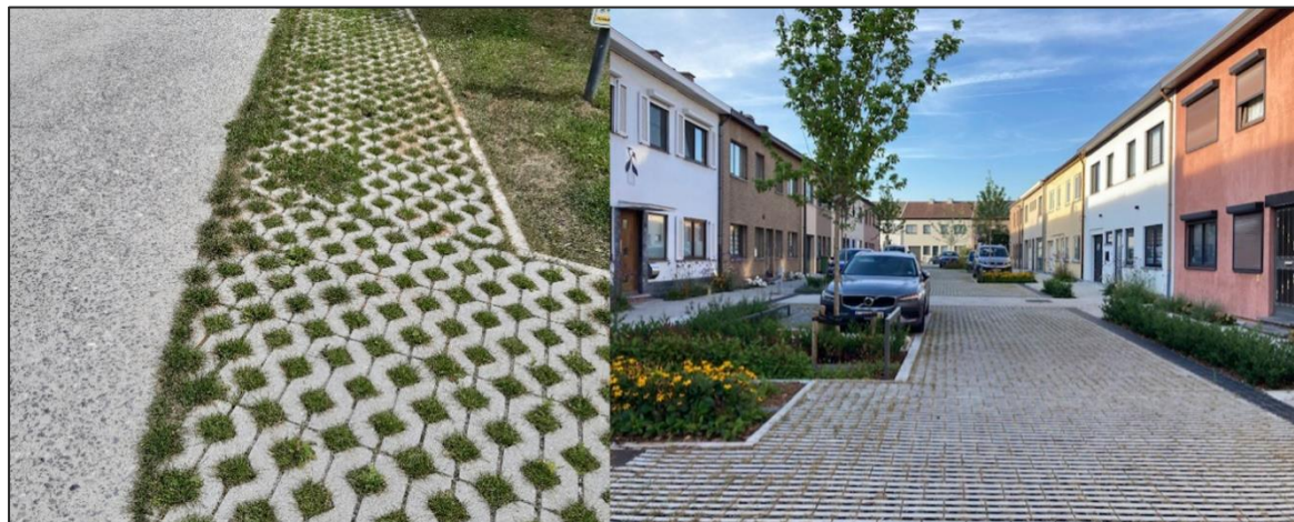
Figuur 28: Vlnr: (1) Versmald voet-fietspad met uitwijkmogelijkheid over waterdoorlatende verharding (Overijse). © Aquafin; (2) Tuinstraat met zowel rijweg als parkeervakken aangelegd in halfverharding (Aziëlaan, Wilrijk). © Aquafin.
