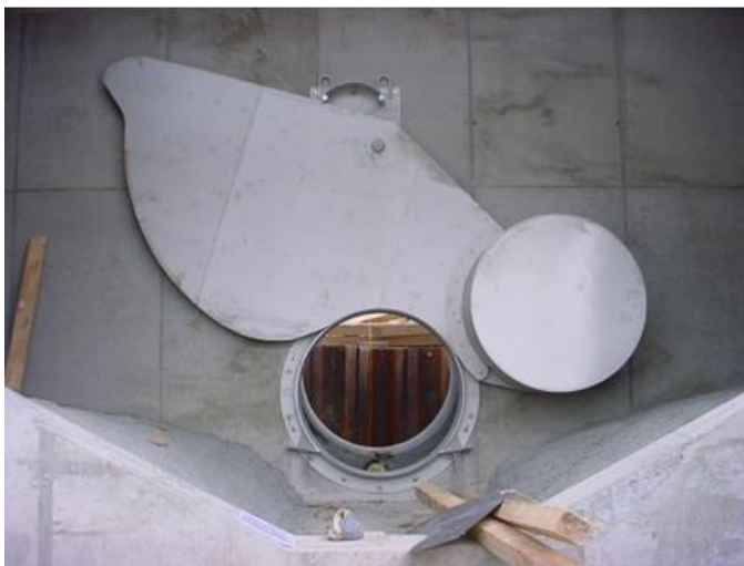
Figuur 69: Links: Debietregelaar. Bron: Morselt.com. Rechts: Regelbare afsluiter. Bron: KWT.be.
